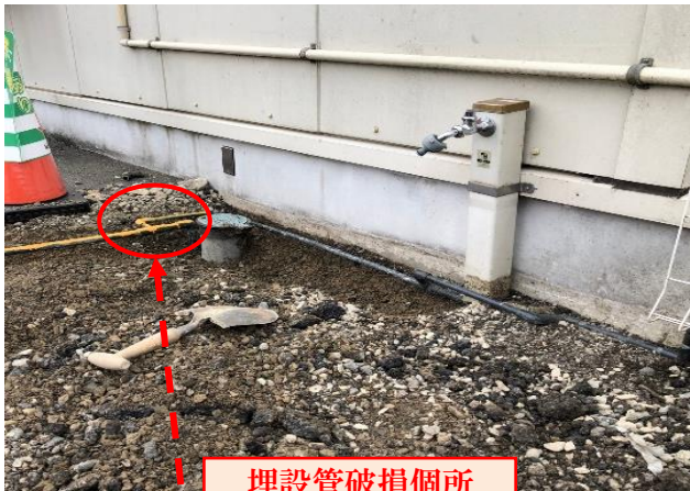
埋設管破損箇所
