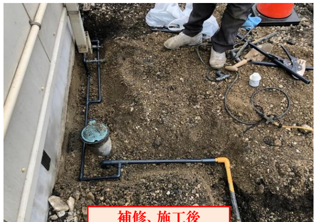
SEJ外構埋設給水管破損
