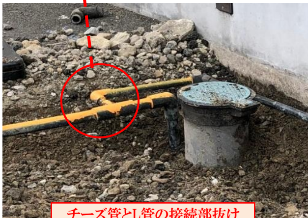
埋設管破損箇所
