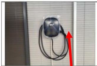
ウォールユニット設置後
