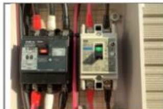
契約ブレーカー及びEVブレーカー新設
