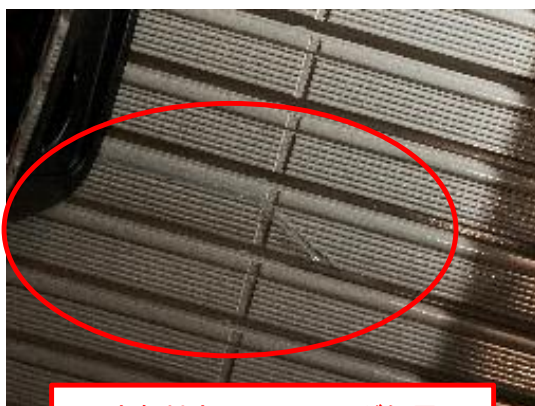
応急対応 : シーリング処置
