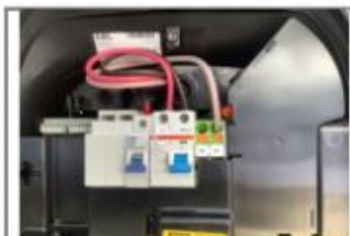
ウォールユニット接続状況
