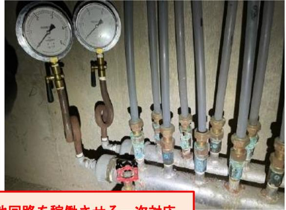
破損させた2回路を閉栓し他回路を稼働させる一次対応
