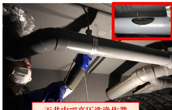
天井内で高圧洗浄作業
