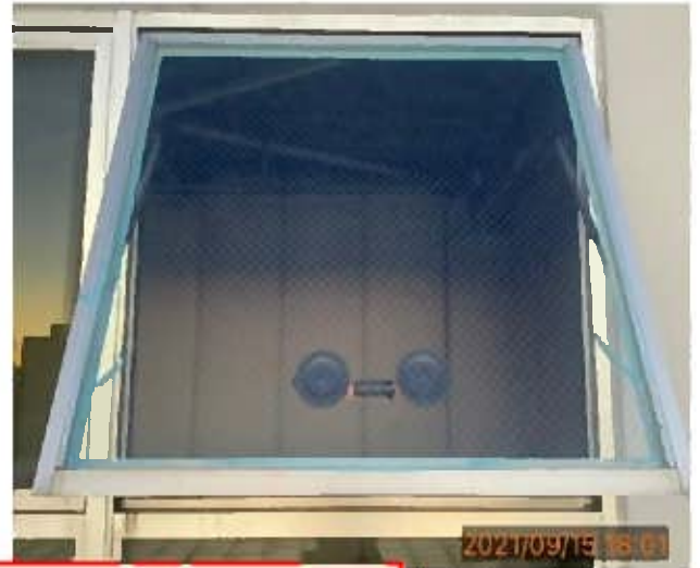
ガラス交換完了
