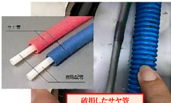
漏水後の壁内点検状況
