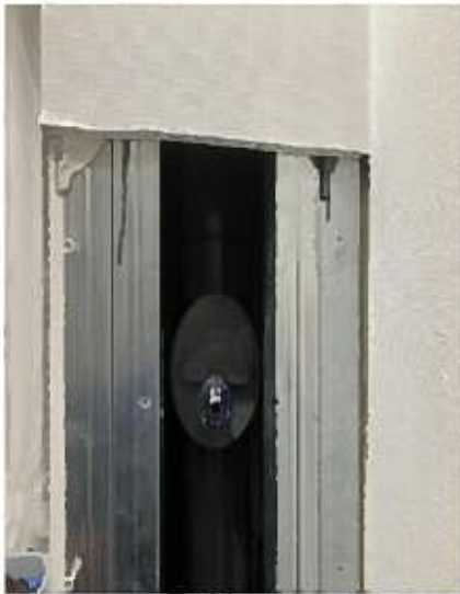
パイプシャフト開口後排水口設置
