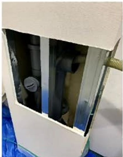
蓄積物バキューム処理 ※ 汚水配管掃除口は新設
