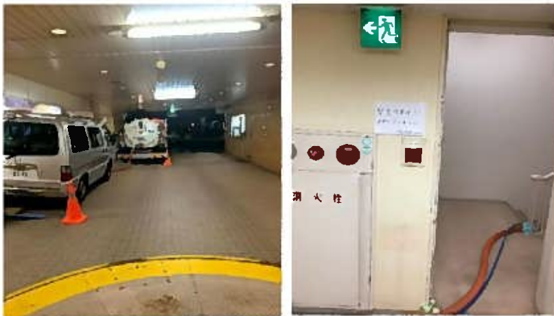
バキューム車からの配管養生状況
