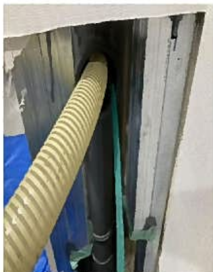
バキューム＋高圧洗浄
