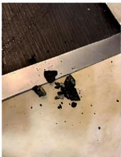
内部金属配管腐食片 バキューム時に採取
