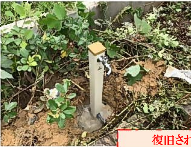
破損した立ち水栓
