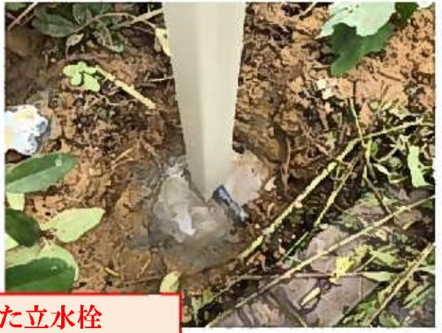
破損した立ち水栓
