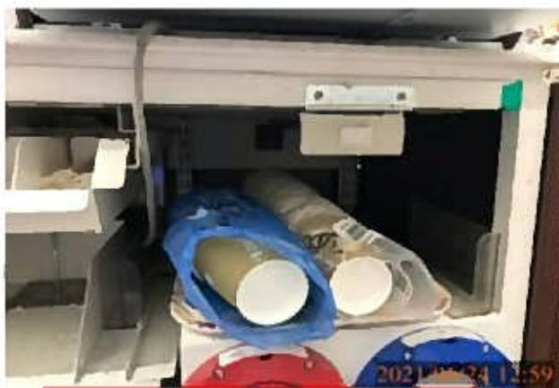
呼び出しブザー移設前状況
