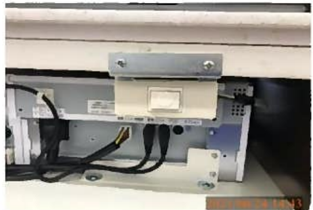
呼び出しブザー移設後状況
