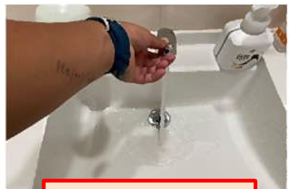
復旧後通水点検
