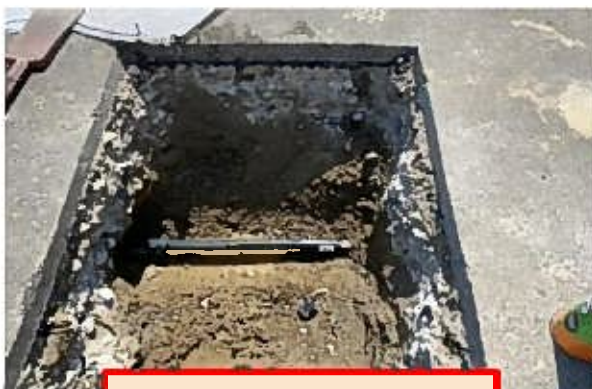
給水管復旧状況
