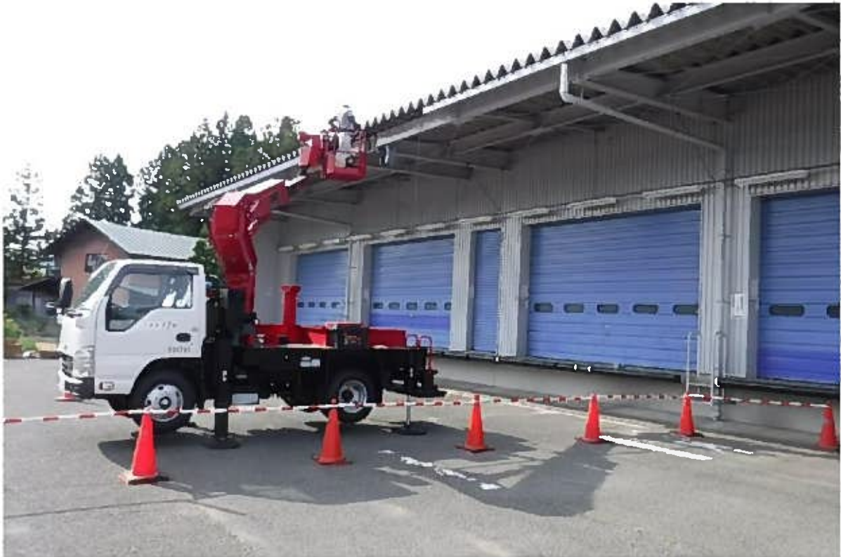
2日目の仮設状況写真
