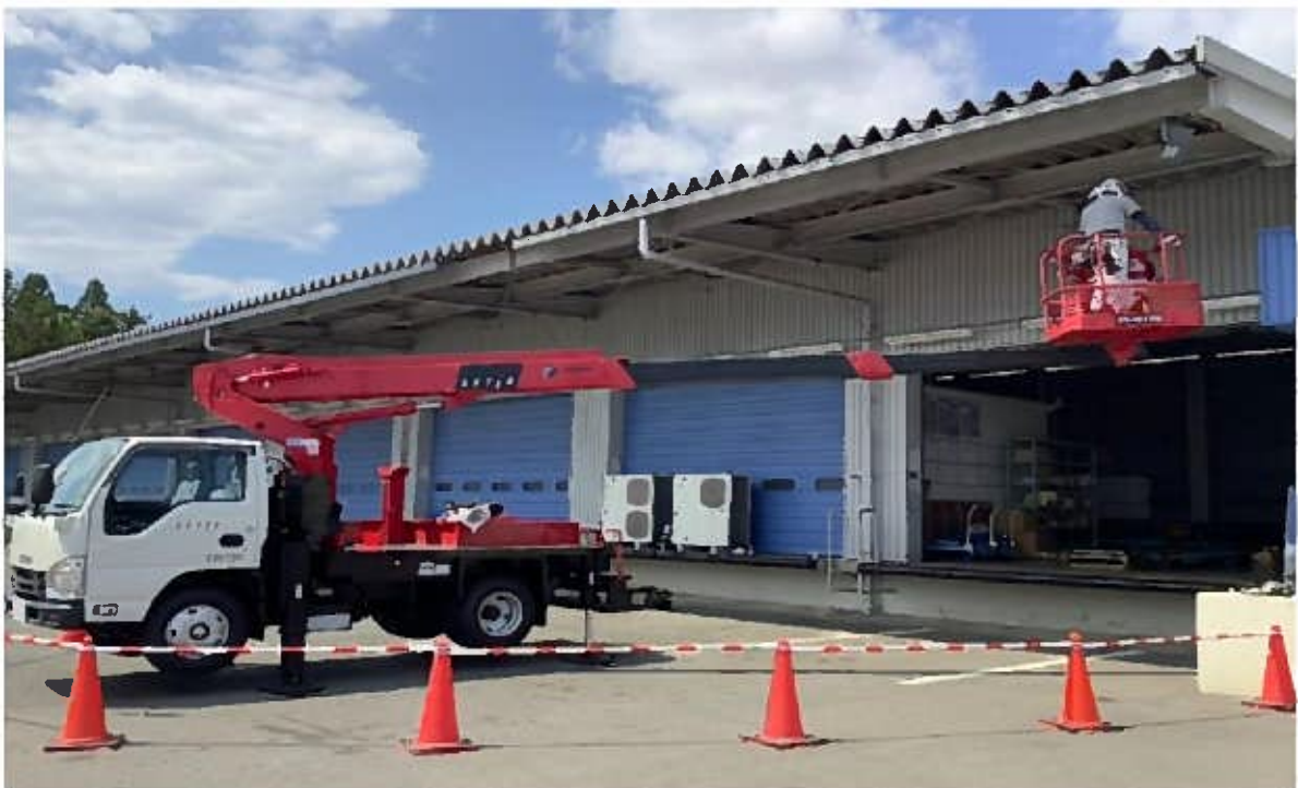
3日目の仮設状況写真
