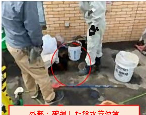
外部：破損した給水管位置
