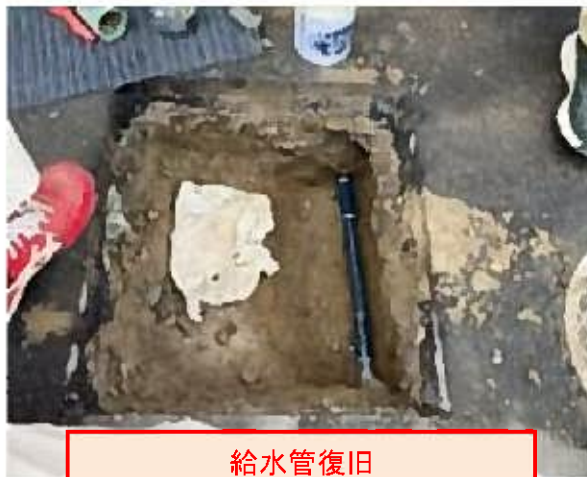
外部：破損した給水管位置
