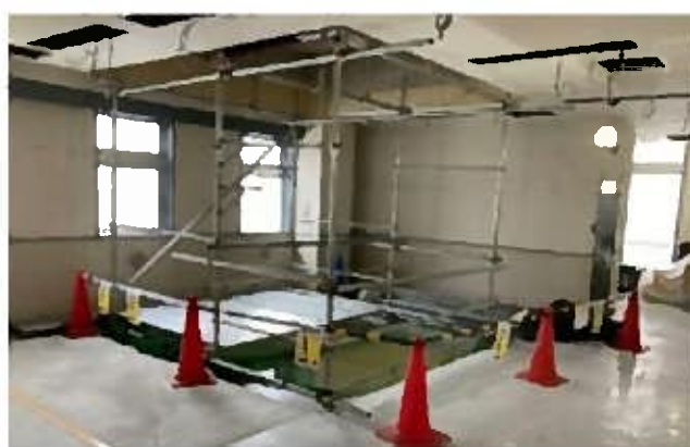
2階吹き抜け部 施工後状況
