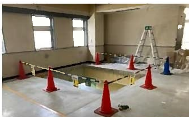
2階吹き抜け部 施工前状況
